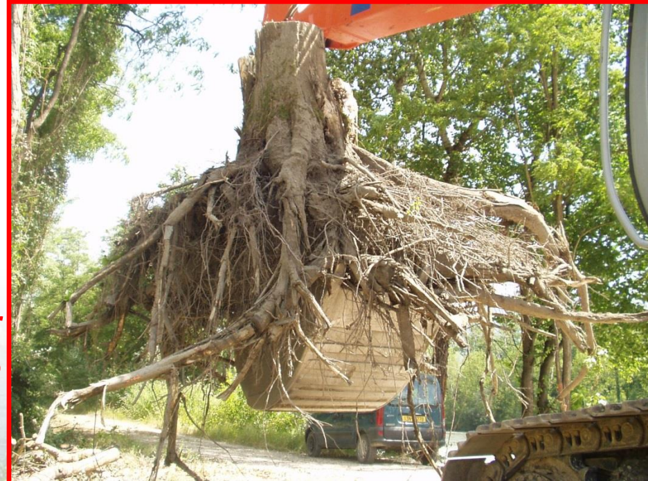
Souche de peuplier extraite d'une digue
