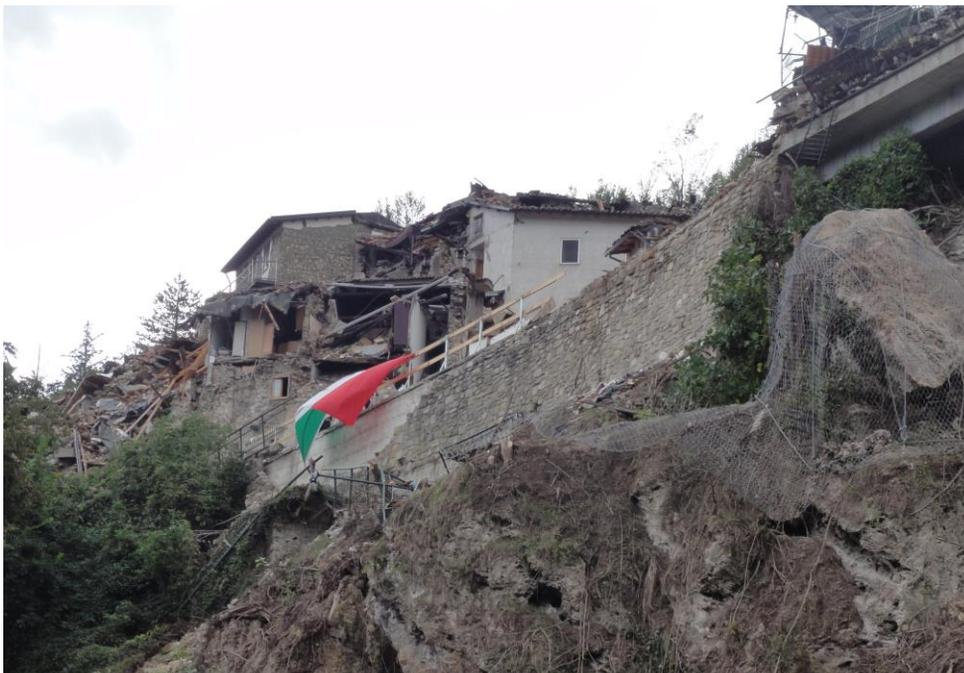
Effet induit (gravitaire) lors du séisme d'Amatrice, Mw: 6.3, 24 Août 2016
